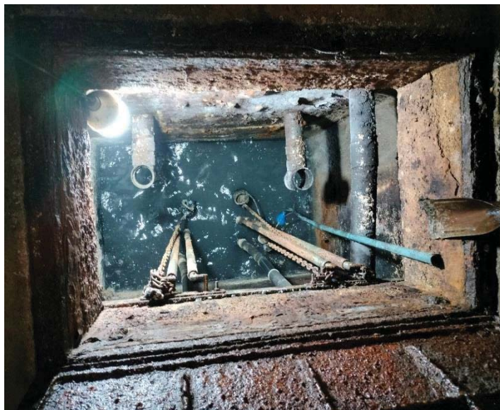
บ่อไขมัน(sump) (Canteen ชั้น B 1) หลังทำเสร็จ
