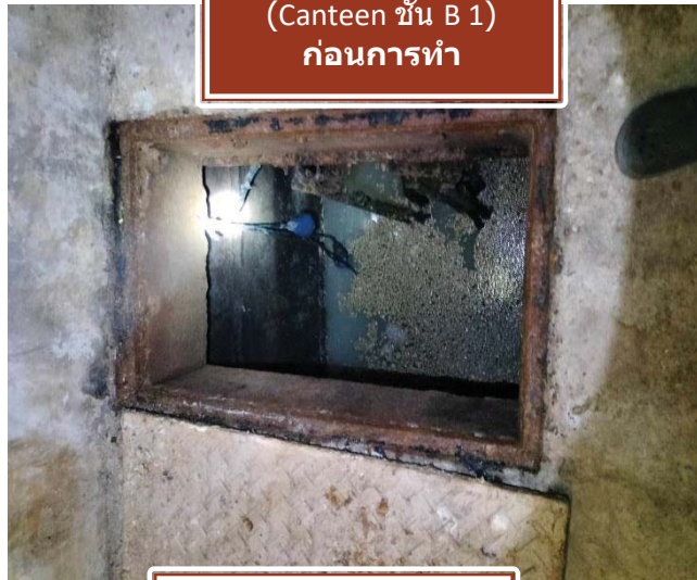
บ่อไขมัน(sump) (Canteen ชั้น B 1) ก่อนการทำ
