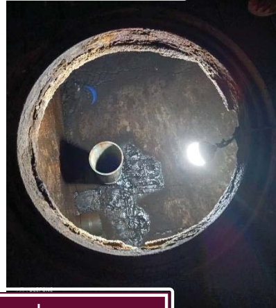
บ่อเกรอะ (แลมปีทางลง) ขณะกำลังทำ
